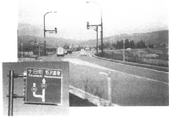
開通をみた国道117バイパス、小沼～大関橋間
